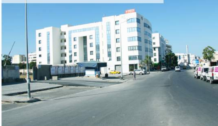
DRAINAGE AND ROAD WORKS IN THE AREA OF « BOURJEL – MONTPLAISIR » EL KHADRA
